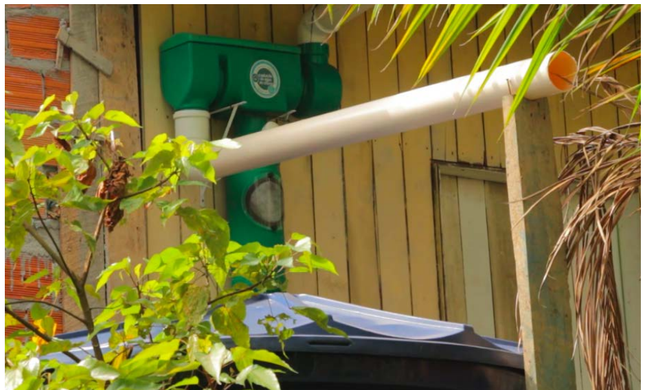
Figura 1. Prototipo de captación de agua de lluvia, Abaetetuba, Pará, Brasil.
