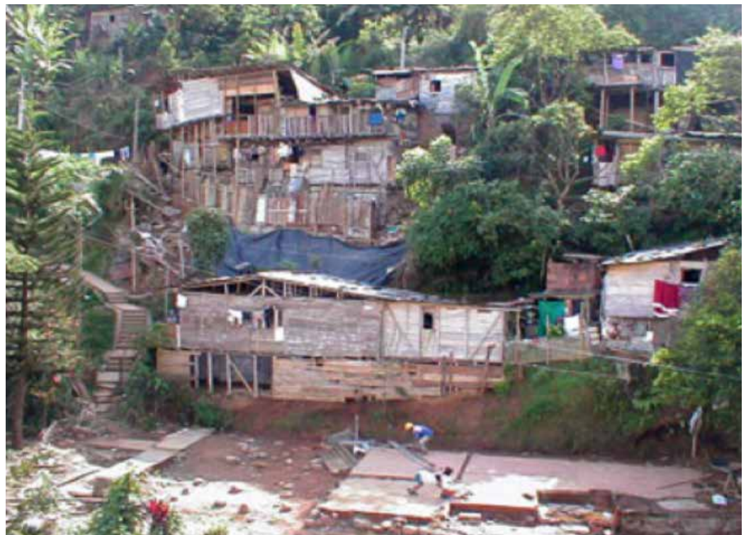
Figura 1: Construcción en ladera de montaña en Dosquebradas.
